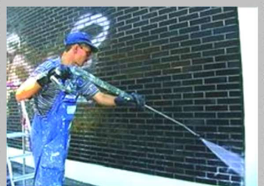
4. die gereinigte Fläche mit AGS 3502 schützen
