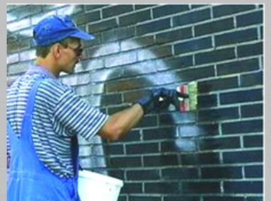
2. mit Pinsel oder Spritzgerät auftragen und einwirken lassen,
